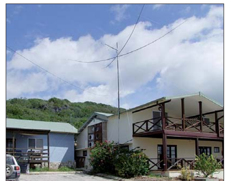
Das „Sunset Hotel“ mit vom Eigentümer fest installierten Antennenmast für Amateurfunkaktivitäten, wir hatten daran unsere Zweielement-Moxon für 20 m und 15 m befestigt.
